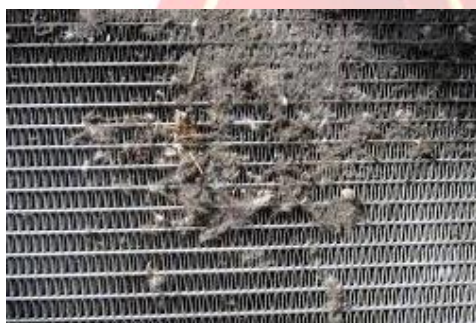
نمونه‌هایی از تجمع بیش از حد آلودگی محیطی بر سطح شبکه
